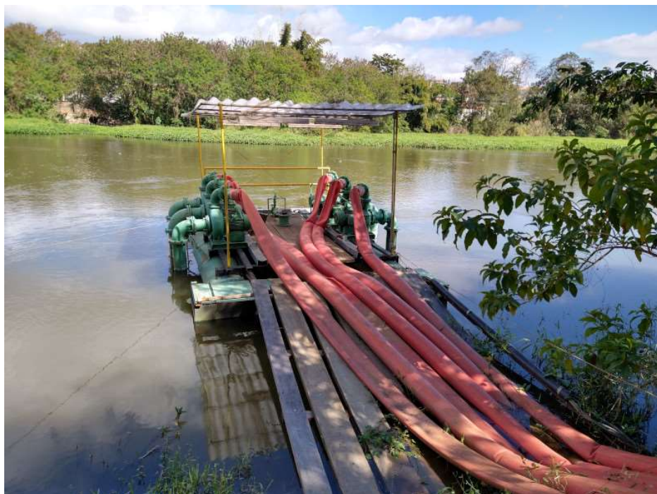
Foto 3 Vista da captação auxiliar flutuante mais antiga e dos mangotes flexíveis de adução até o poço de sucção da captação principal
