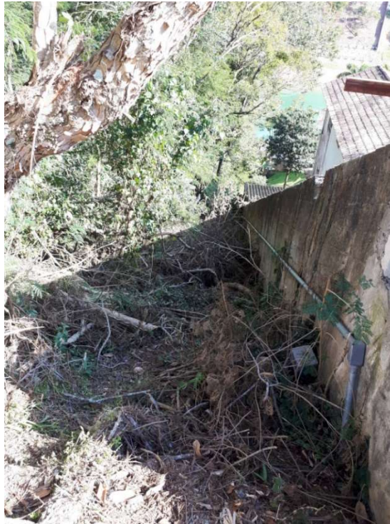
Foto 26 Vista de faixa de terreno desde a rua até a captação da ETA 2 localizada à margem do reservatório do Jáguari. À direita, muro de divisa com a propriedade particular que dá acesso à captação.
