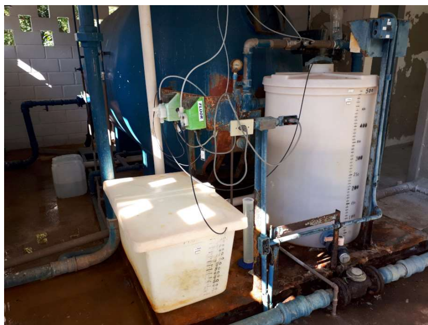
Foto 33 Vista do filtro horizontal sob pressão e, em primeiro plano, sistemas de armazenamento e dosagem de hipoclorito de sódio e ácido fluossilícico
