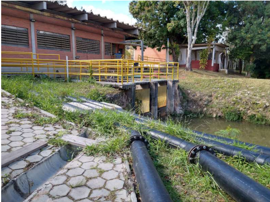
Foto 2 Vista dos tubos rígidos de PEAD de adução da captação auxiliar mais nova até o poço de sucção da captação principal
