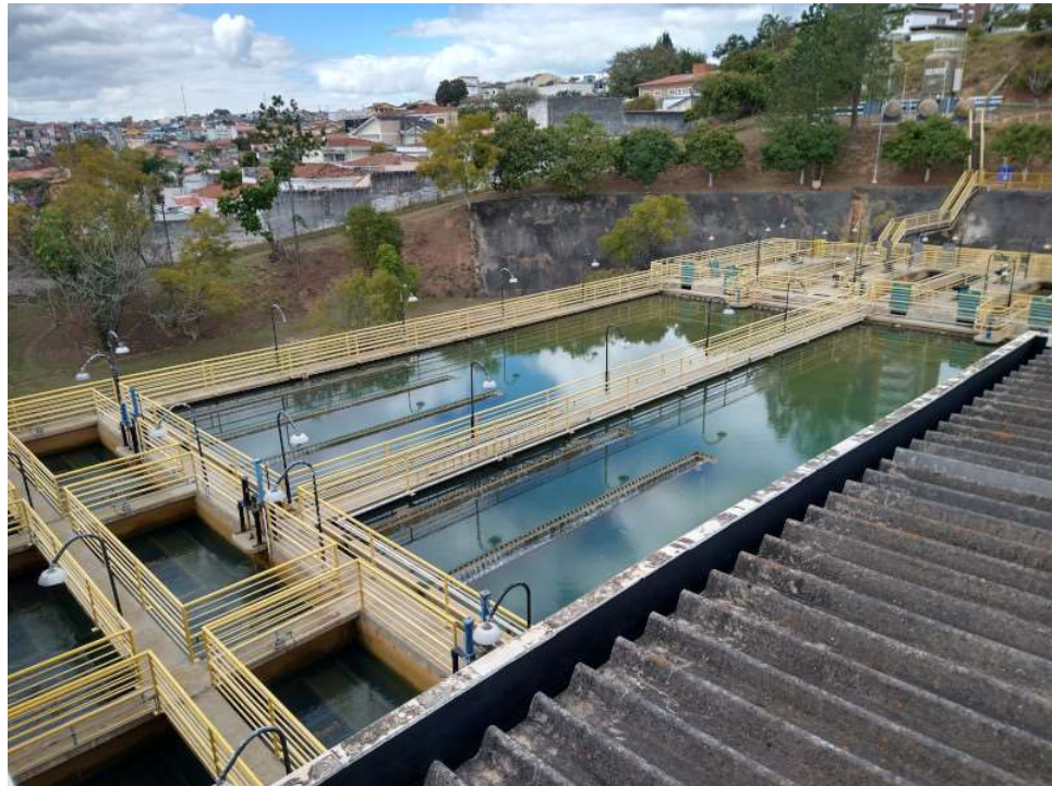
Foto 9 Vista geral de um dos módulos de tratamento.
