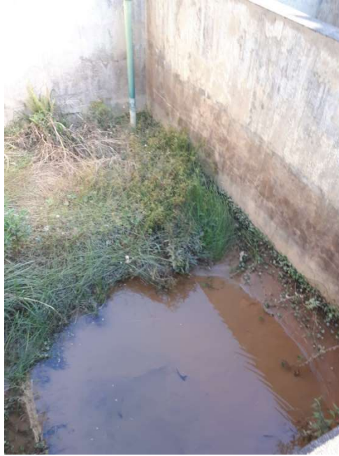
Foto 20 Vista de um dos tanques de armazenagem de efluentes, atualmente desativado
